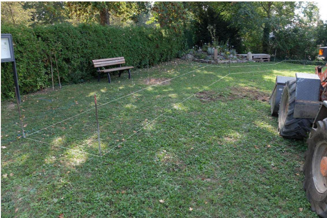
Im Zuge der Arbeiten zur Erweiterung des Bereichs der Urnenbäume wird auch der Grabsteinweg entstehen. Hier ist er abgesteckt und lässt seine Form erahnen.
