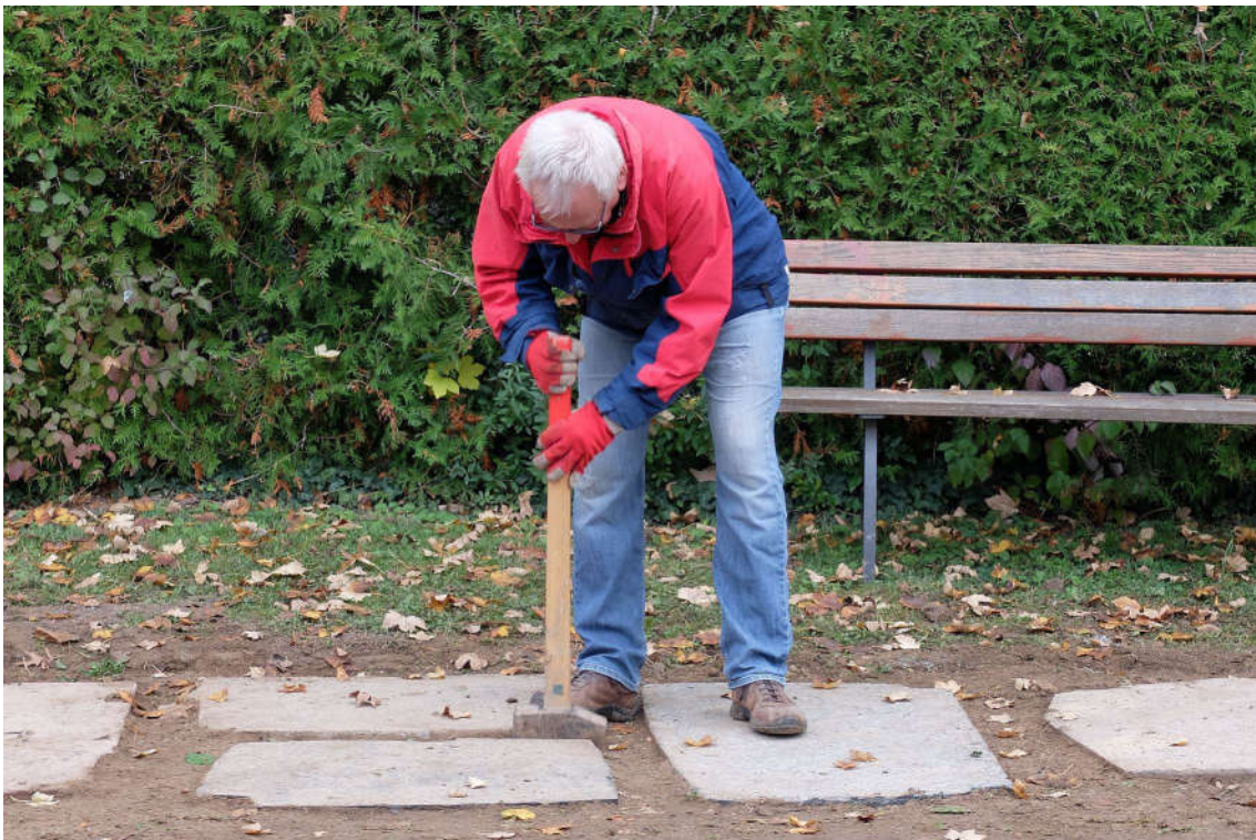
Bevor weitere Erde in die Zwischenräume gefüllt werden kann, muss die Erde verdichtet werden.
