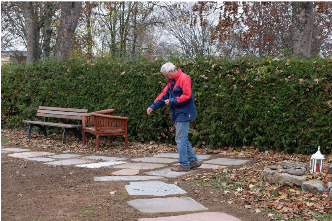
Die letzten Arbeiten sind gärtnerischer Art: Aussäen des Grassamens ...
