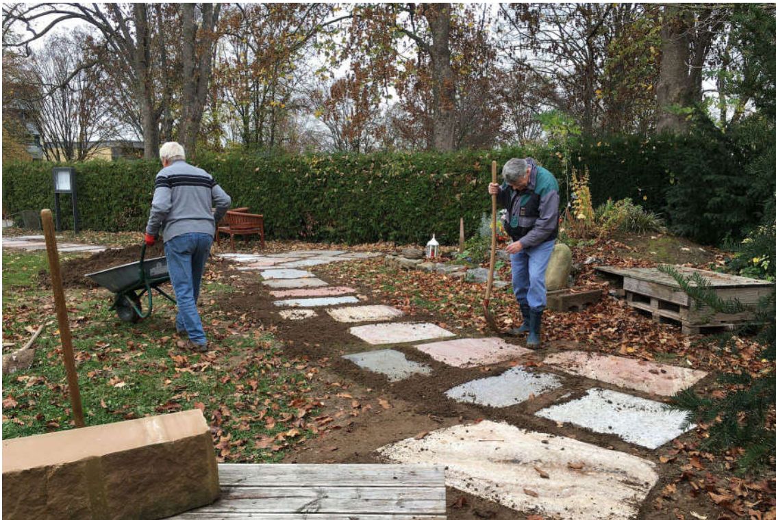
Die Zwischenräume zwischen den Steinen werden mit Erde verfüllt.
