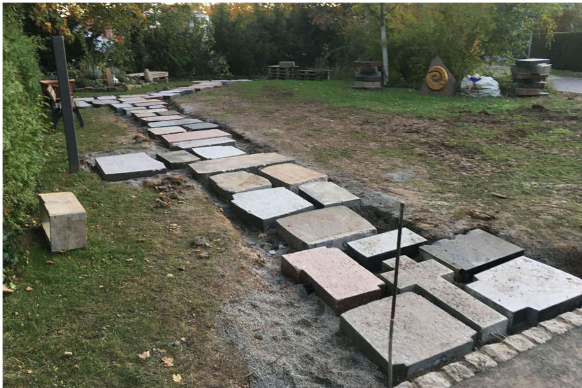
Die Steine liegen - die weiteren Arbeiten werden vom Ewig-anders-Team in Eigenleistung erbracht.
